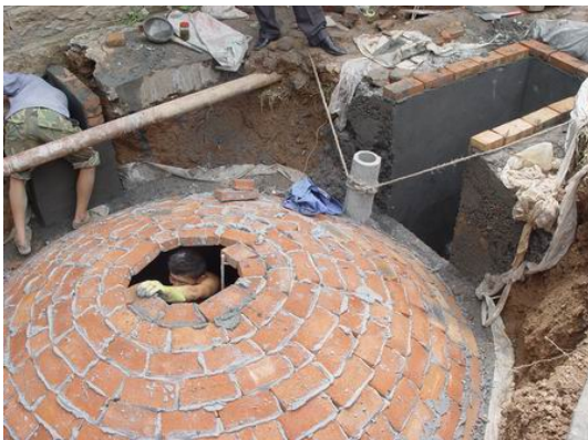
Biodigesteur à dôme fixe © Initiative Développement
