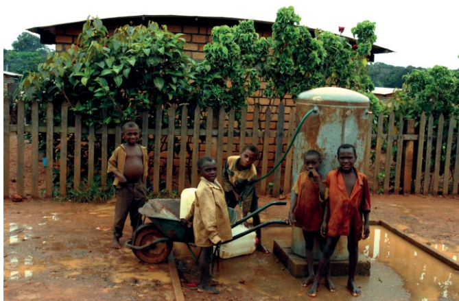
Borne d'approvisionnement en eau potable au village forestier de Loundoungou
