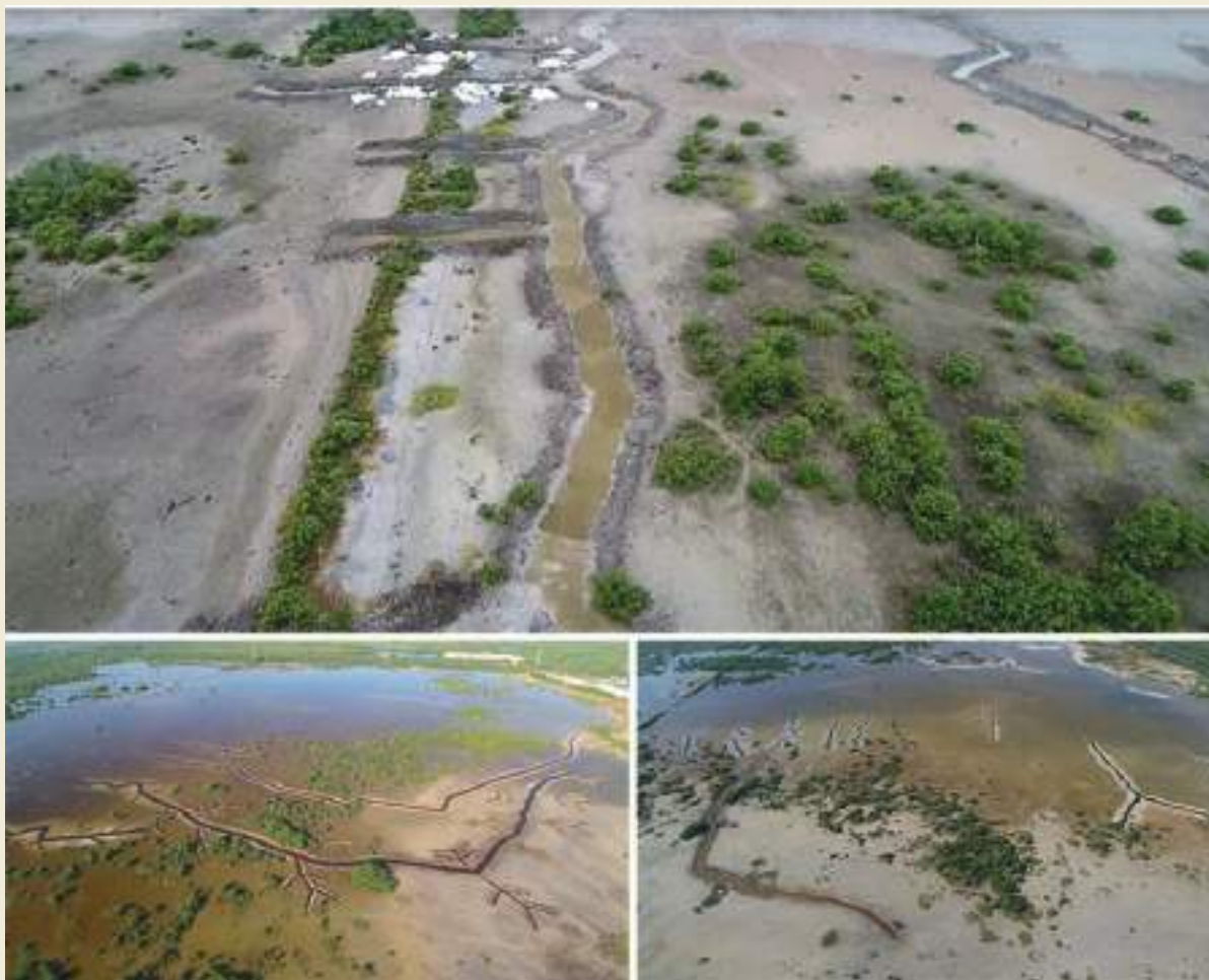
Figura 2.32 — Vista aérea con fotos tomadas con un dron de una zona en restauración en Progreso Yucatán, México.
