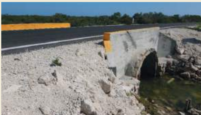
Paso de agua obstruido por escombros
