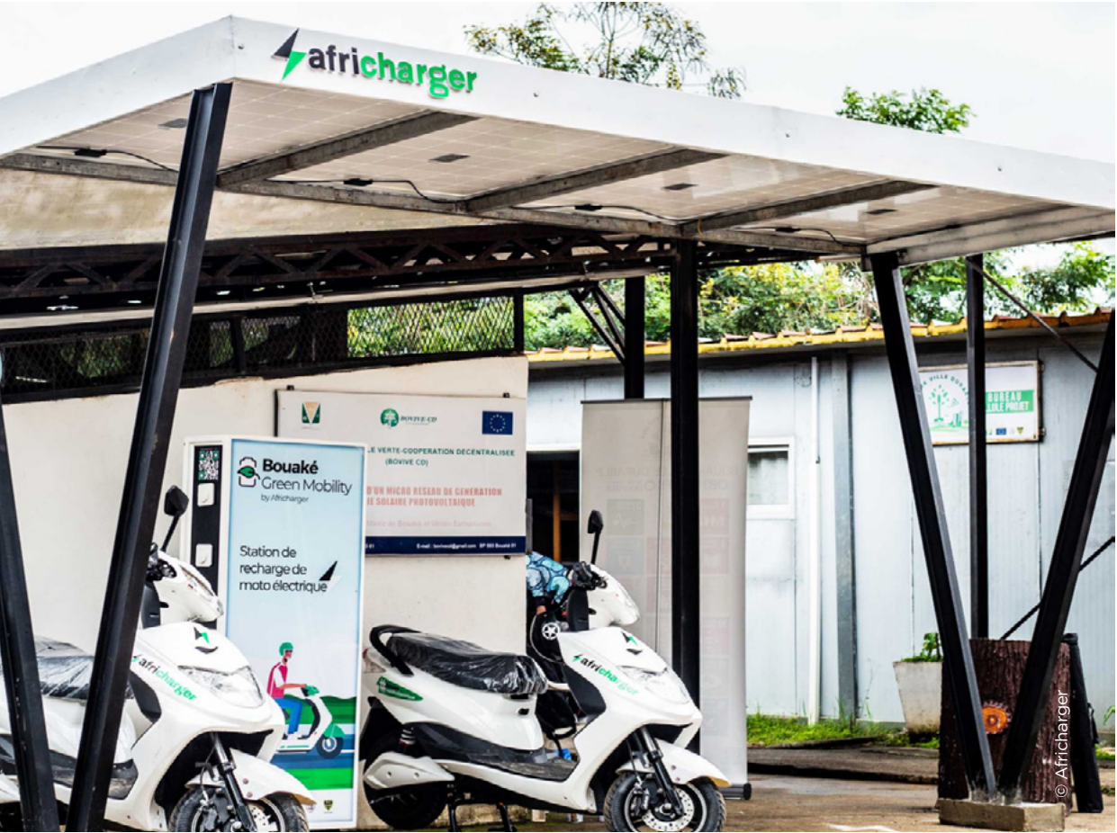
Image 44 : Première station de recharge de moto électrique solaire à Bouaké.
