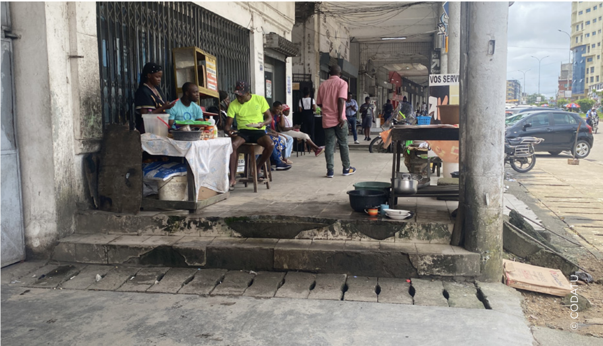
Image 25 : Discontinuité d'une galerie piétonne à Douala.
