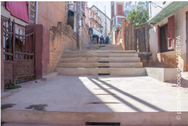
Image 34 : Aménagement d'un escalier.
